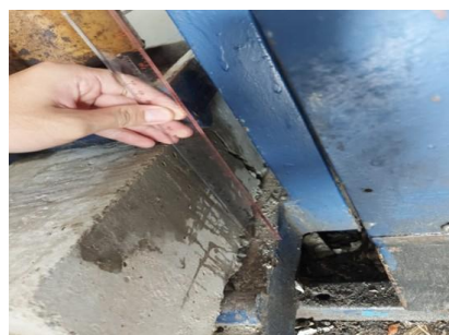
Gambar 12. Pengukuran Nilai Lendutan Beton
