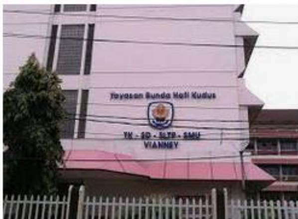
Gambar 1. Gedung Sekolah SD Vianney
