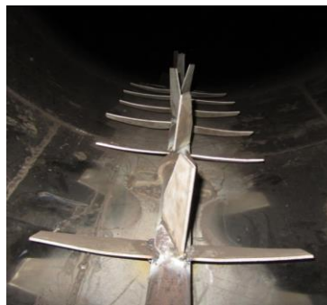
Gambar 19. Implementasi Modifikasi Dredging
